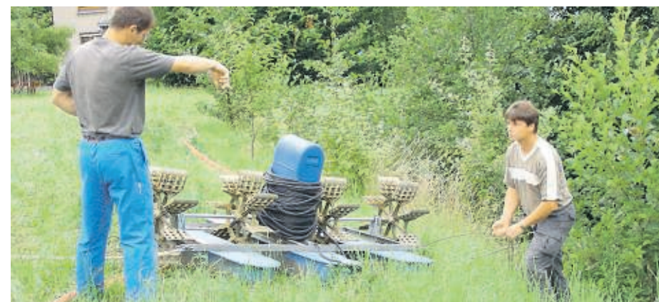
Stefan Größler und Ronald Greif ziehen einen Oberflächenbelüfter in den unteren Teich des Regenrückhaltebeckens, um das Wasser mit Sauerstoff anzureichern.
